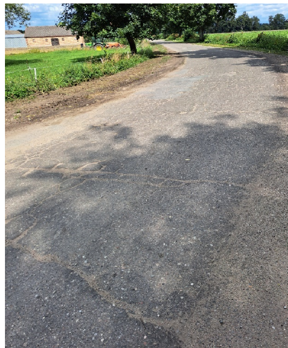
Fot. 53. Droga powiatowa asfaltowa – miejscowość Pluskocin.
