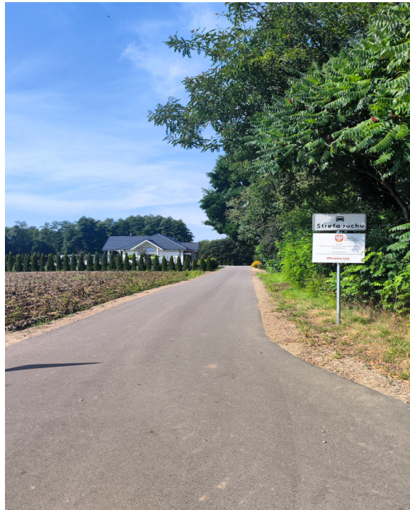
Fot. 51. Droga gminna asfaltowa – miejscowość Podmarszczyn.
