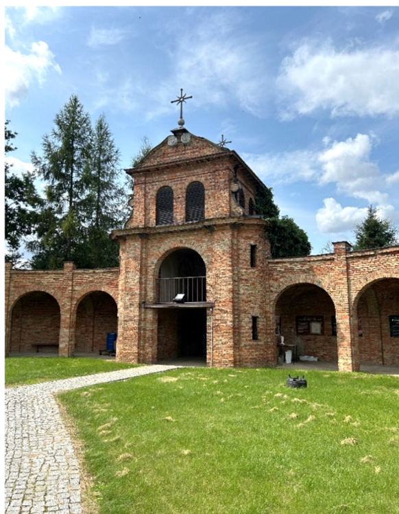
Fot. 18. Dzwonnica Skołatowo.
