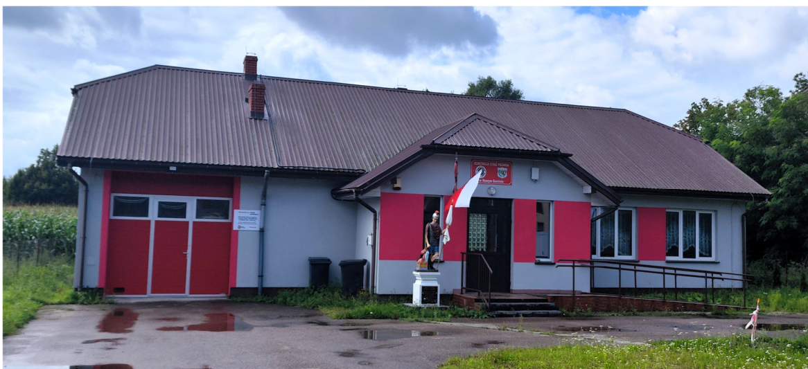
Fot. 47. Remiza Ochotniczej Straży Pożarnej w Nowym Guminie.
