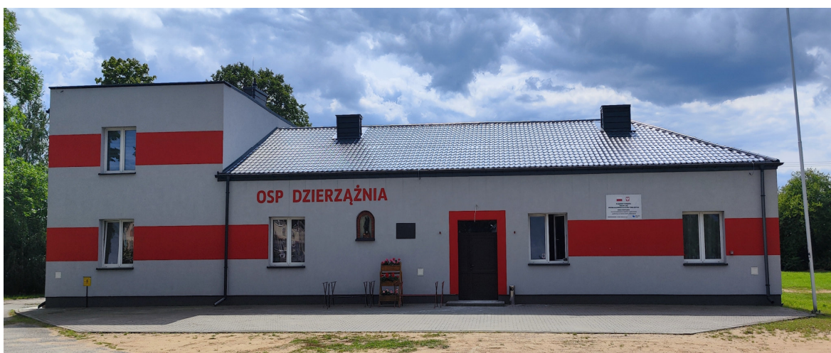
Fot. 45. Remiza Ochotniczej Straży Pożarnej w Dzierżążni.
