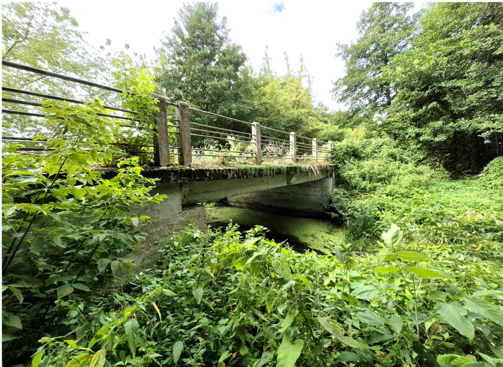
Fot. 67. Most na rzece Żurawianka w miejscowości Wilamowice.
