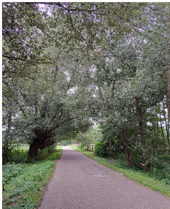
Fot. 52. Droga gminna asfaltowa – miejscowość Gumowo.
