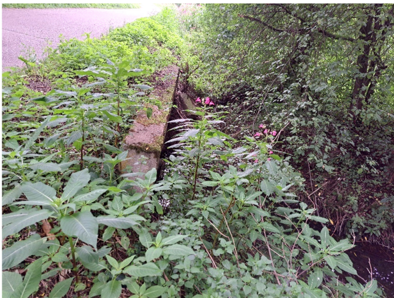
Fot. 74. Przepust na rzece Płonka w miejscowości Gumowo.
