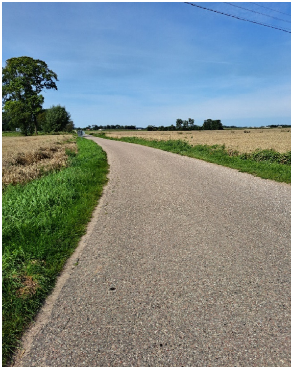
Fot. 50. Droga gminna asfaltowa – miejscowość Starczewo-Pobodze.
