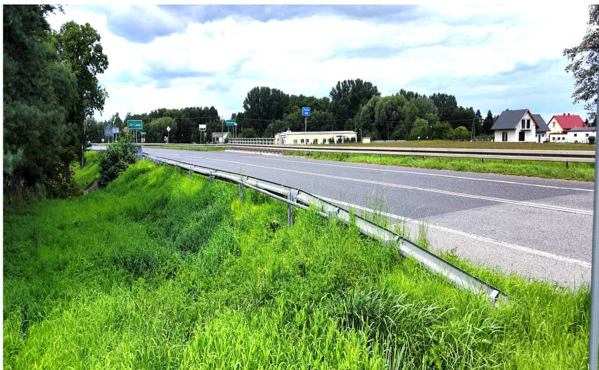
Fot. 69. Most na rzece Płonka w miejscowości Dzierżążnia.
