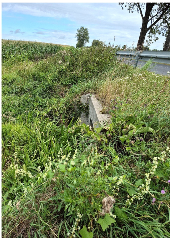
Fot. 72. Przepust na rzece Dzierżążnica w miejscowości Błomino-Jeże.
