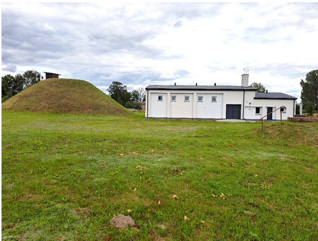
Fot. 60. Stacja uzdatniania wody w miejscowości Nowe Sarnowo.
