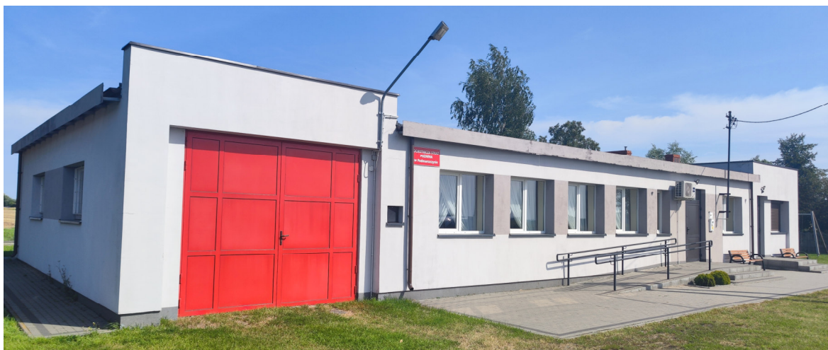
Fot. 49. Remiza Ochotniczej Straży Pożarnej w Podmarszczynie.
