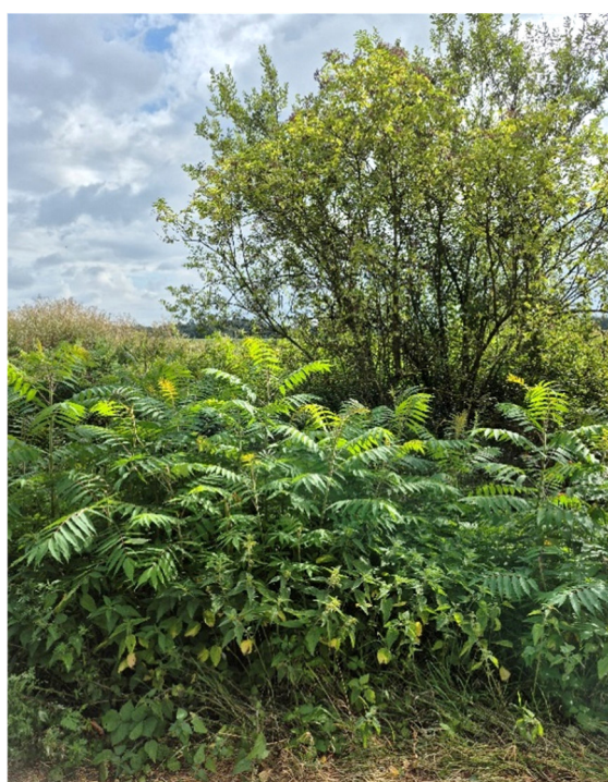
Fot. 62. Rów w złym stanie w miejscowości Niwa.
